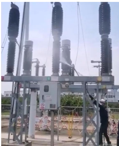
Slika 5: Čišćenje izolatora prekidača 110 kV
