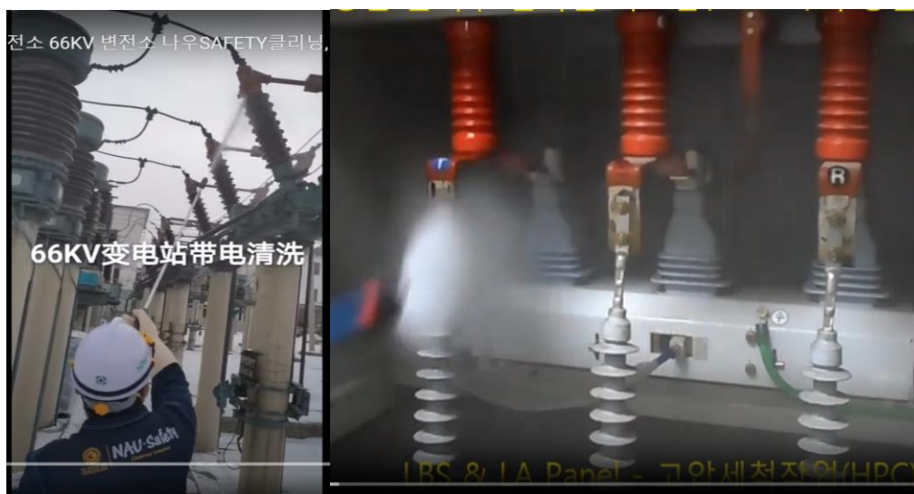
Slika 3: Čišćenje izolatora rastvaljača 66 kV (levo), čišćenje izolatora VN opreme 24 kV (desno)
